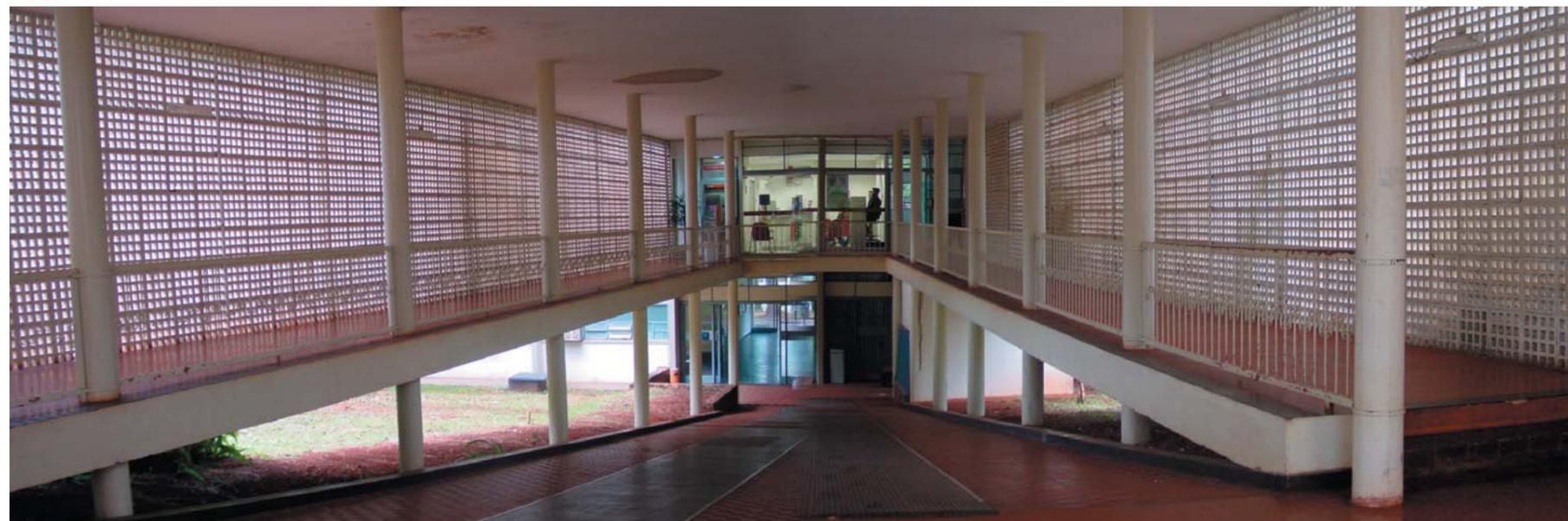
03 Rampa interna fora da norma para acessibilidade (Bloco “F” da FORP).
