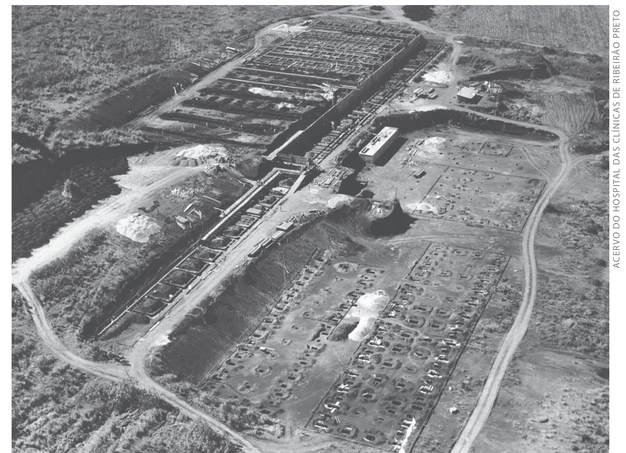
Construção do Hospital das Clínicas (foto tirada entre 1962 e 1978)
