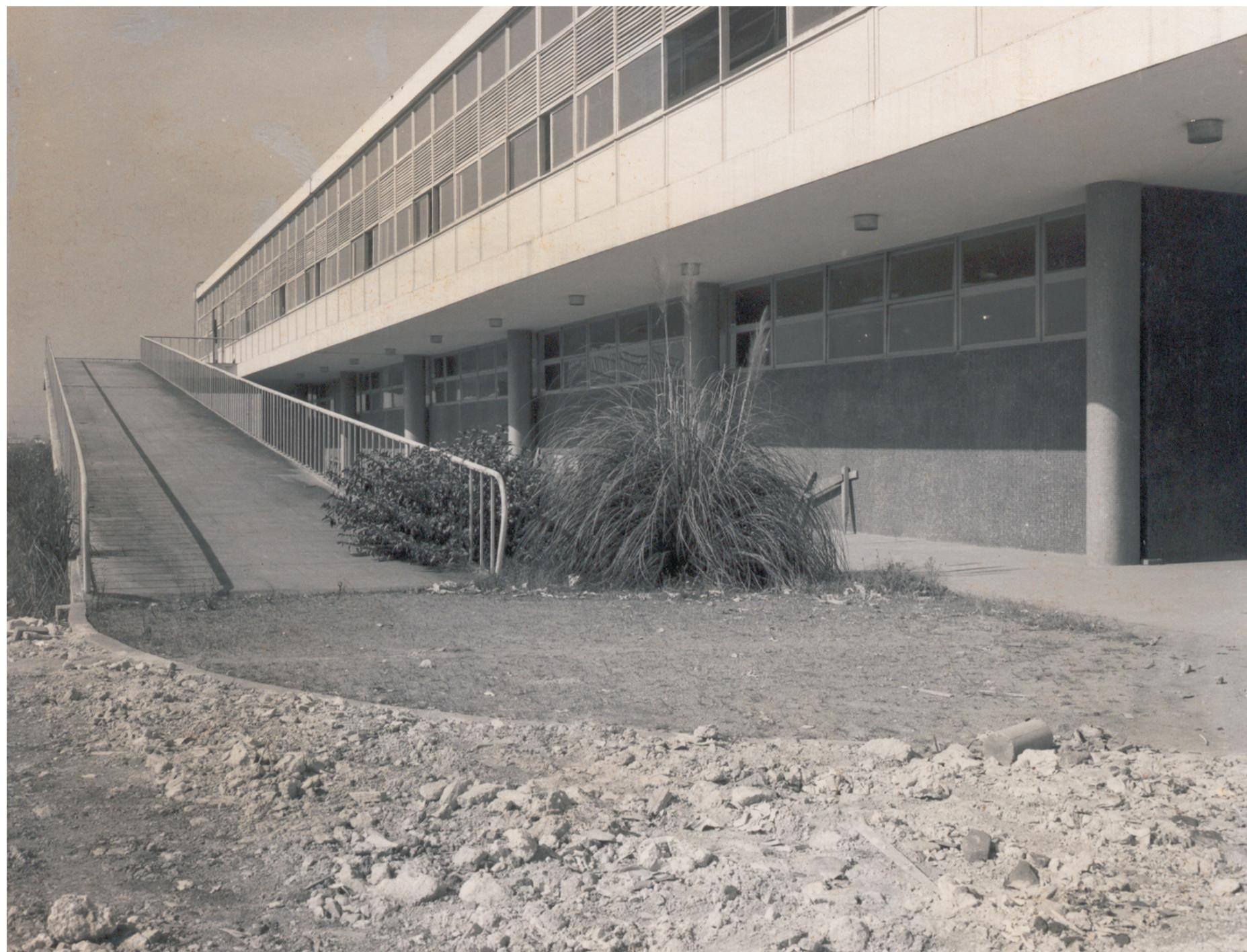
Rampa demolida na extremidade do Bloco B (a mais próxima ao Córrego Pirajussara). Notem-se os caixilhos originais e a área de sombreamento no Pavimento Térreo. As paredes do térreo situam-se atrás dos pilares.
