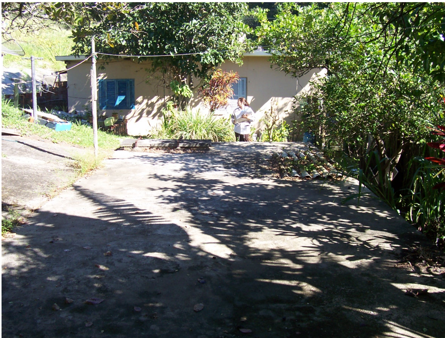
SS03-CAIXA D'ÁGUA DA SABESP COM SS04-CASA DO ZELADOR AO FUNDO
