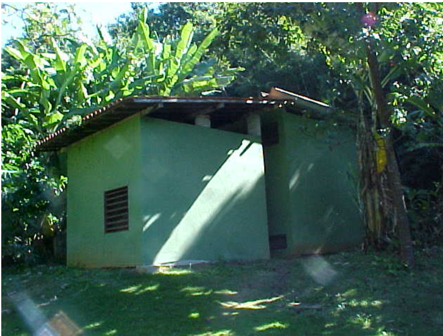
SS18 E SS19-CABINE DE FORÇA
