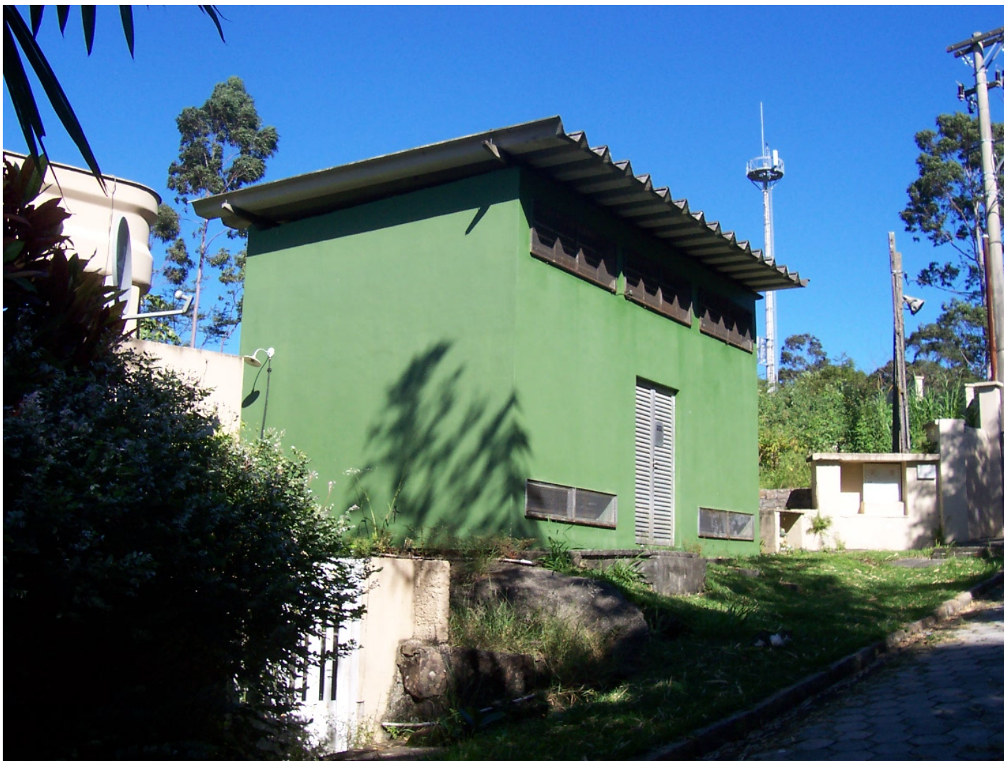
SS05-CABINE DE FORÇA
