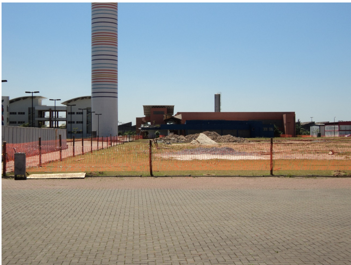
Foto 03 – Detalhe do cercamento da área AI-01 adjacente ao edifício I1.
