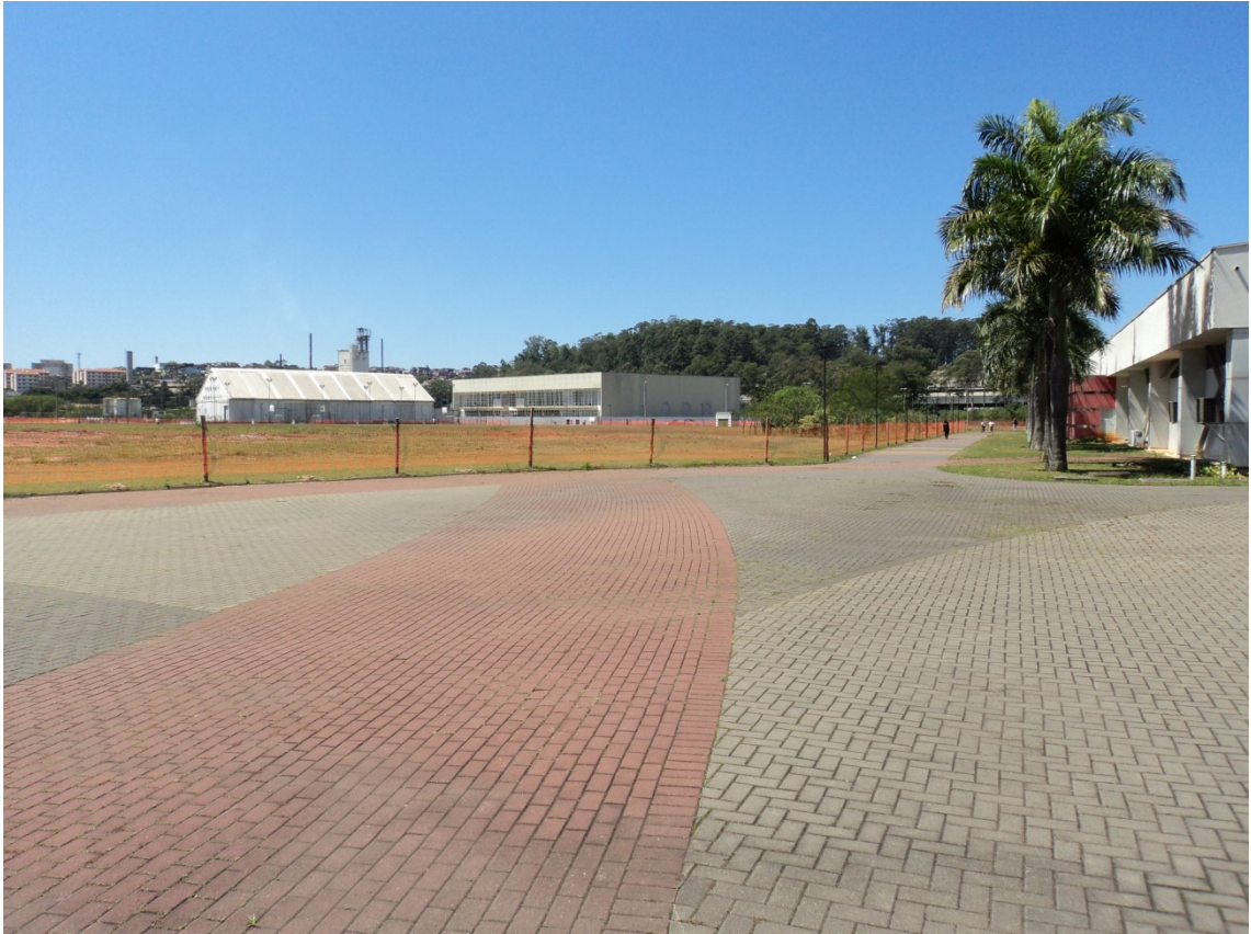
Foto 02 – Detalhe do cercamento da área AI-01 adjacente à biblioteca.
