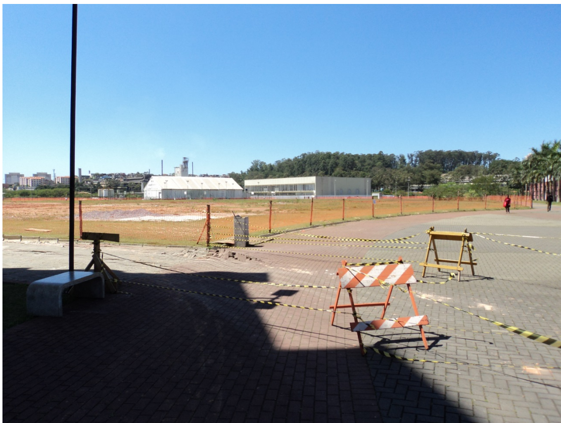
Foto 01 – Detalhe do cercamento da área AI-01.
