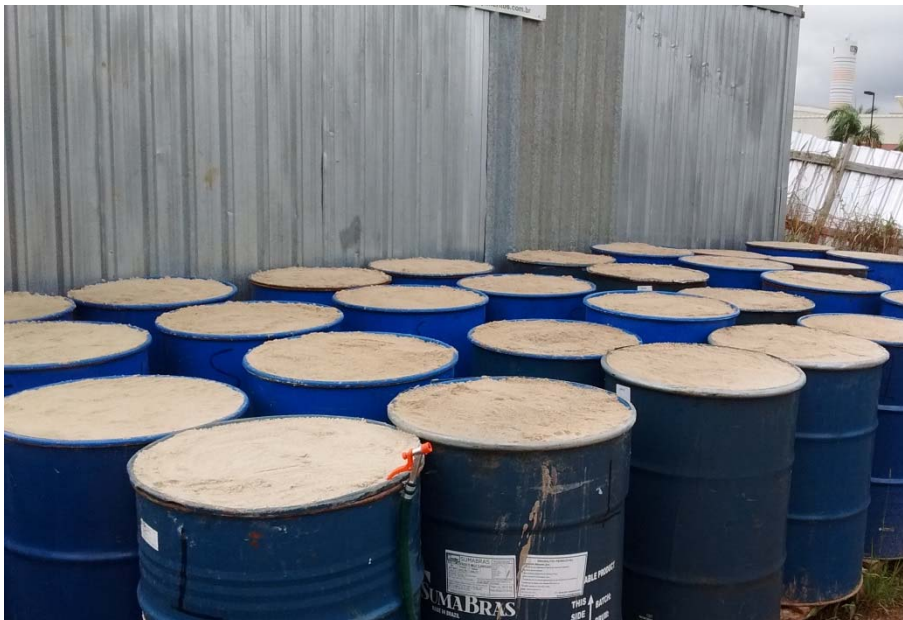
Foto 2 – Acondicionamento de solo e resíduos em tambores de 200L
