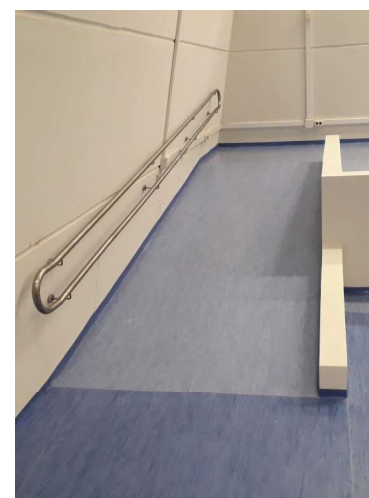
Rampa de acesso ao palco do auditório
