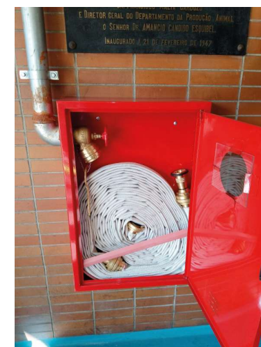
Instalação de hidrantes
