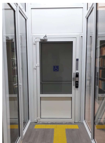
Elevador instalado na biblioteca
