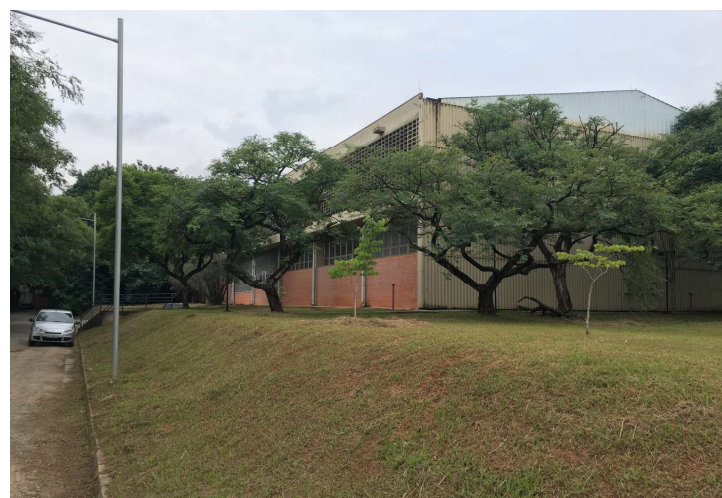
Vista geral do Bloco C em sua elevação Norte
