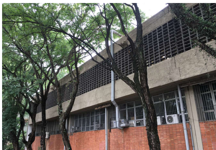
Situação atual da elevação norte do Bloco C
