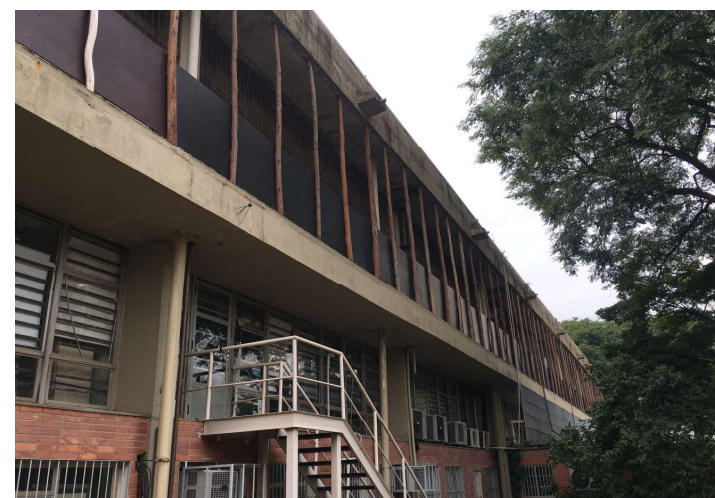
Situação atual da elevação sul do Bloco C
