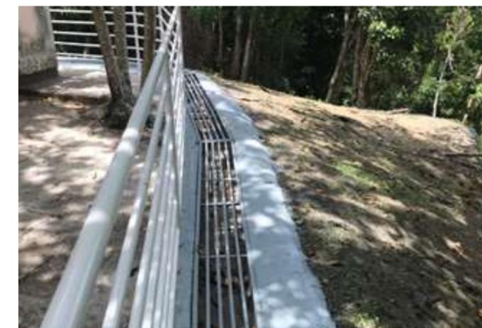
Construção de canaleta com grelhas para contenção da águas pluviais
