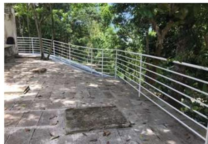
Instalação de guarda-corpo e rejuntamento das placas do piso
