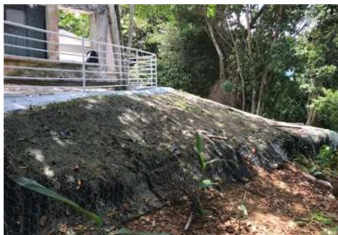
Preparação do talude e recebimento da hidrossemeadura [grama esmeralda]
