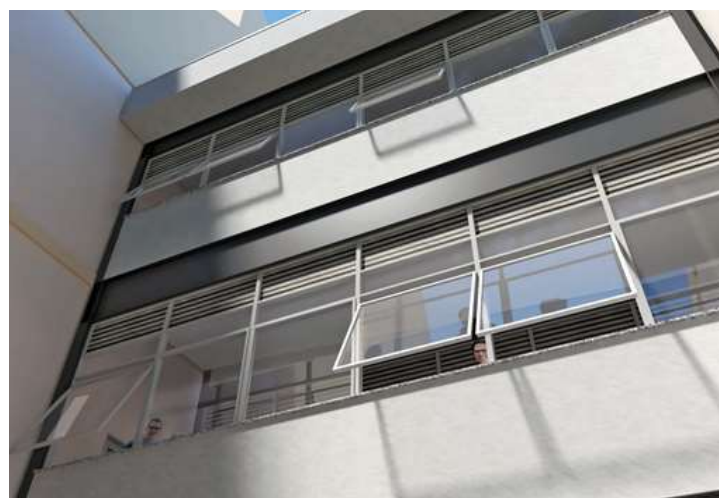
Detalhe das esquadrias
