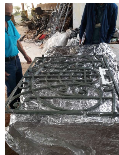
Trabalho de recuperação dos elementos.
