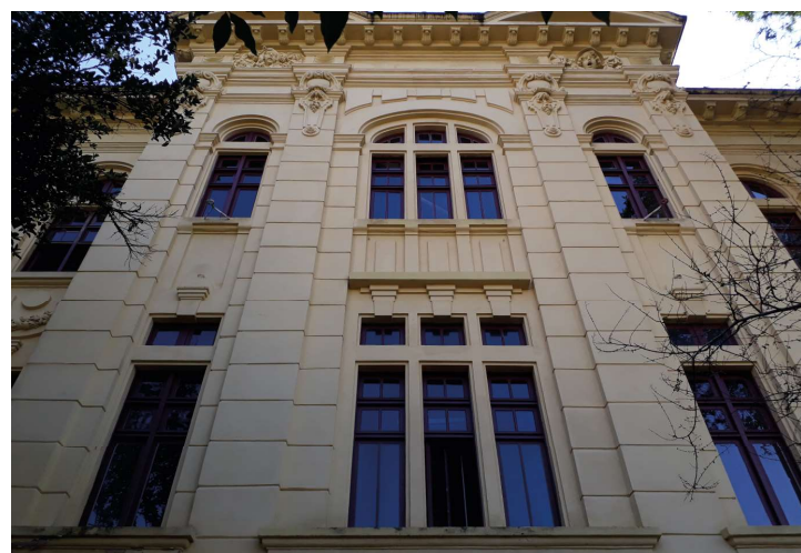
Vista geral de uma das fachadas com as esquadrias recuperadas.
