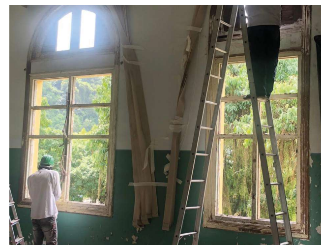
Execução da recuperação das esquadrias em uma das salas.
