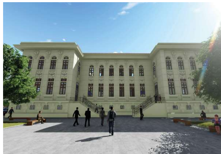
Nova praça de acesso do edifício
