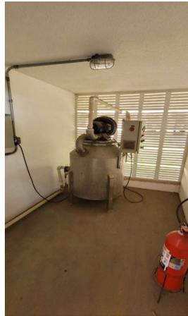
Abrigo Conjunto Laboratorial (A1) com sua célula de vácuo. Neste conjunto laboratorial, não existe sistema de tubulação exposta com as válvulas para redirecionamento, porém, este direcionamento é realizado dentro dos shafts do edifício, onde há uma caixa no chão expondo o entroncamento da tubulação.
