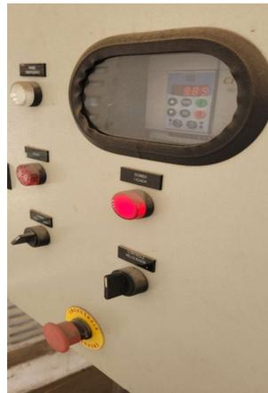
Célula de vácuo e painel mostrando funcionamento. As tubulações ficam na lateral do edifício com suas devidas válvulas para redirecionamento do vácuo e todo este conjunto do ciclo básico segue esta mesma configuração das tubulações.
