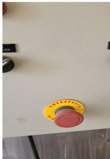
Célula de vácuo e painel mostrando funcionamento. O painel está com mau contato no botão de emergência, onde ocasionalmente aciona o alarme sonoro. Pode ser apenas sujeira ou já falha elétrica mesmo nesta botoeira. É necessária uma manutenção corretiva para sanar o problema.
