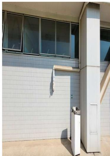
Imagem do abrigo, célula de vácuo e sistema de tubulações da lateral do edifício I1. Este edifício, por ser muito comprido, possui um abrigo em cada extremidade para dividir a carga das células de vácuo. Saliento que este abrigo tende a puxar uma água mais barrenta.
