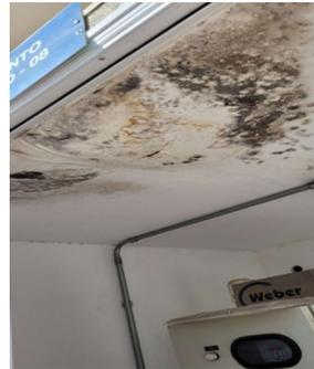
Este abrigo é feito em Drywall e está com infiltração no teto. Segundo o responsável pelo departamento de manutenção da EACH/USP, seria viável refazer este abrigo em alvenaria. A caixa de energia despreendeu da parede, porém recentemente o funcionário da manutenção a fixou. Célula de vácuo operando normalmente.
