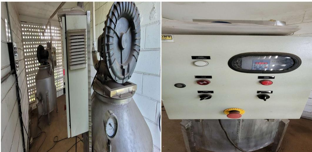
Células de vácuo do Abrigo Biblioteca com registro do painel eletrônico mostrando que está funcionando normalmente. Saliento que existe histórico em época de chuvas em que a quantidade de água puxada pela célula de vácuo é maior, sendo assim, é necessário sempre verificar a existência de água ao abrir o dreno na parte inferior.
