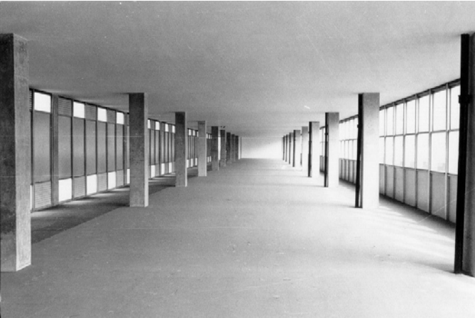
Reforma do Bloco F. Janeiro de 1975.
