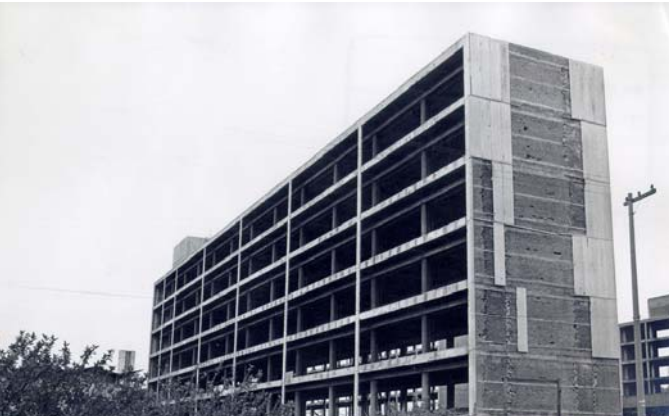
Reforma da estrutura do Bloco G. Cerca de 1975.
