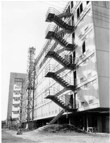
Fachada Sul do Bloco D. Em primeiro plano a escada de incêndio original. Outubro de 1975.
