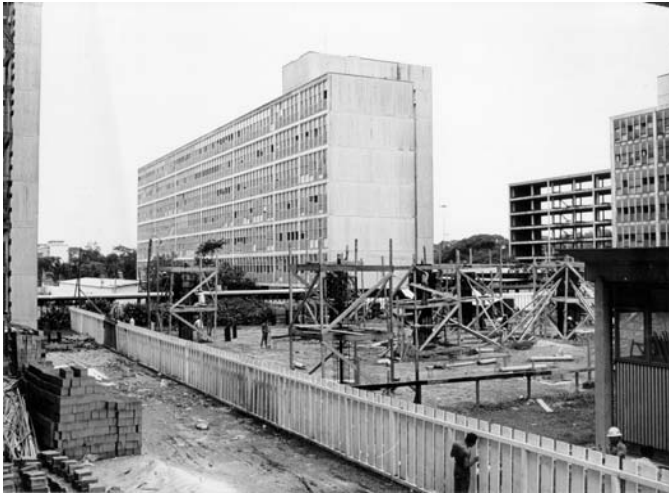
Reforma do Bloco F. Janeiro de 1975.
