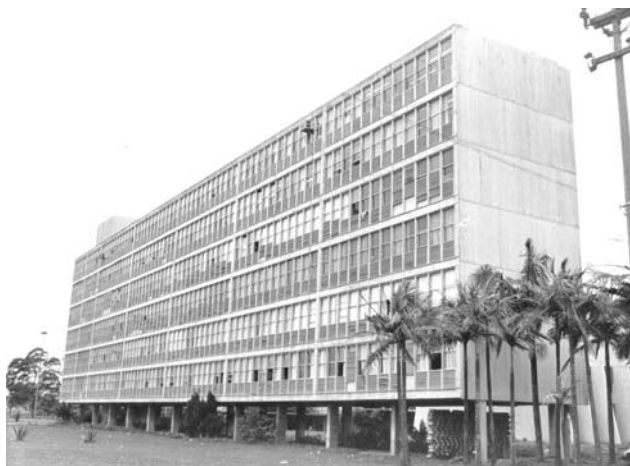
Fachada Norte do Bloco A. Dezembro de 1975.
