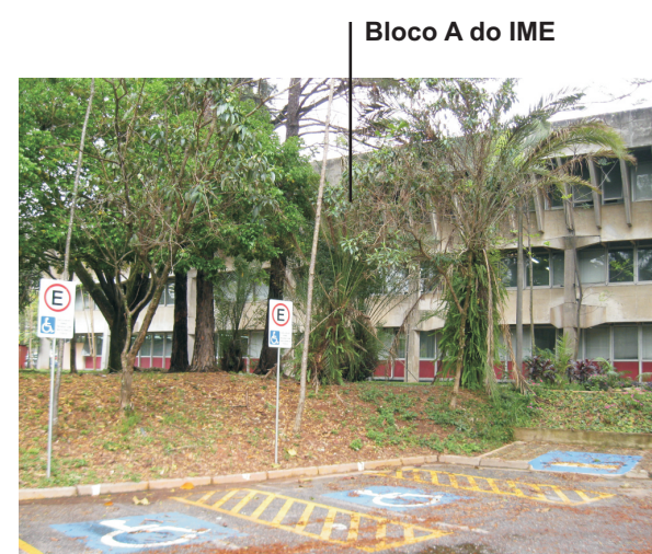
Figura 4 - Vagas para deficientes junto à entrada de veículos do IME, não existindo acesso nesta fachada do Bloco A. Novas vagas para deficientes foram propostas no estacionamento junto à Rua V e no pavimento D-1 (garagem).
