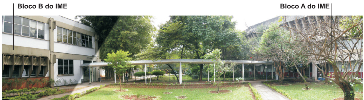
Figura 7 - Cobertura que será substituída por uma construção em dois pavimentos, criando o eixo de ligação dos blocos A e B do IME.
