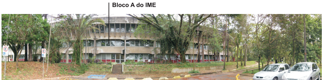
Figura 5 - À direita, acesso de veículos que leva para atual estacionamento entre os blocos A e B, onde será a nova praça e café do IME; este acesso deverá ser mantido apenas para carga e
