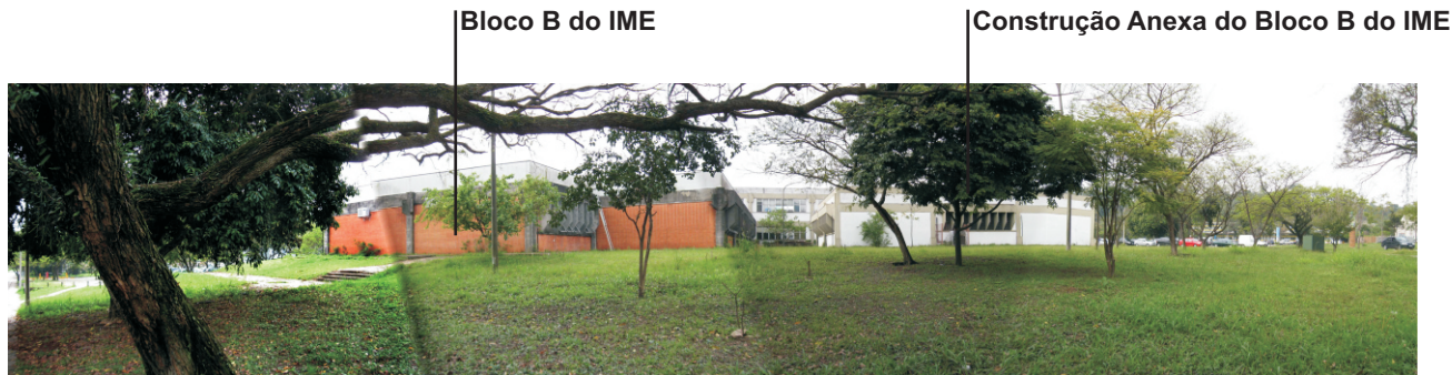
Figura 10 - Vista desde a Rua V da área para a expansão do IME, local do futuro Bloco D.
