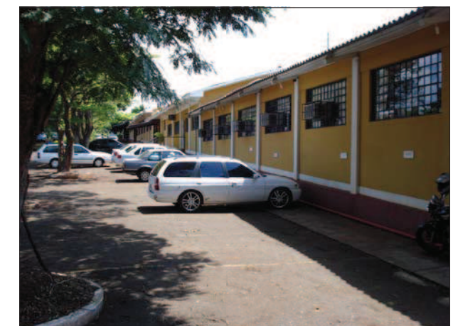
Figura 26 - Área frontal à atual Biblioteca - Ausência de calçadas Out 2007
