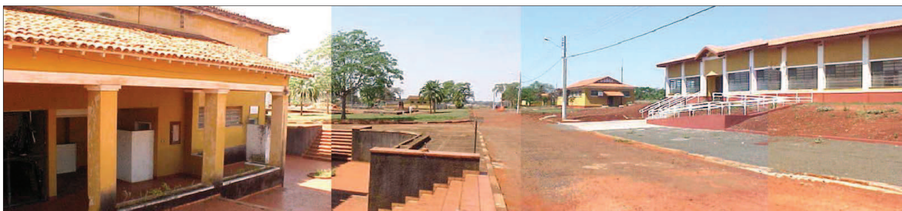
Figura 72 - Via construída junto à escadaria posterior do edifício da Arquibancada - Proposta de calçamento nesse trecho Set 2006
