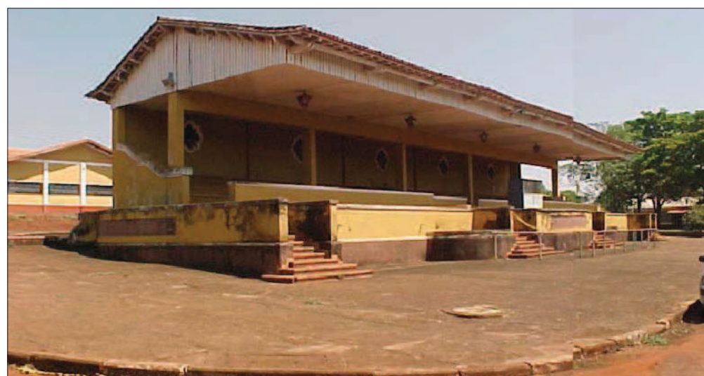
Figura 56 - Edifício da Arquibancada a ser restaurado Set 2006
