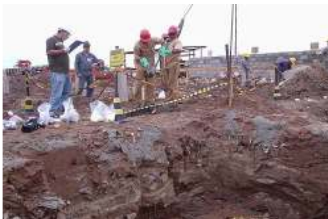
Foto 3- Resíduos (plásticos, embalagens e borrachas), em escavações de baixa profundidade (cerca de 2 metros) (de Servmar, 2005).
