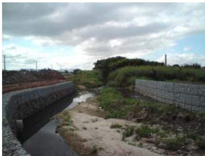
Foto 2- Córrego limite noroeste a montante da área vendo-se ao fundo chaminé antiga indicada no Desenho A1, Anexo A.
