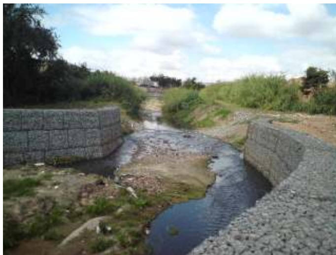
Foto 1- Córrego limite noroeste a montante da área.
