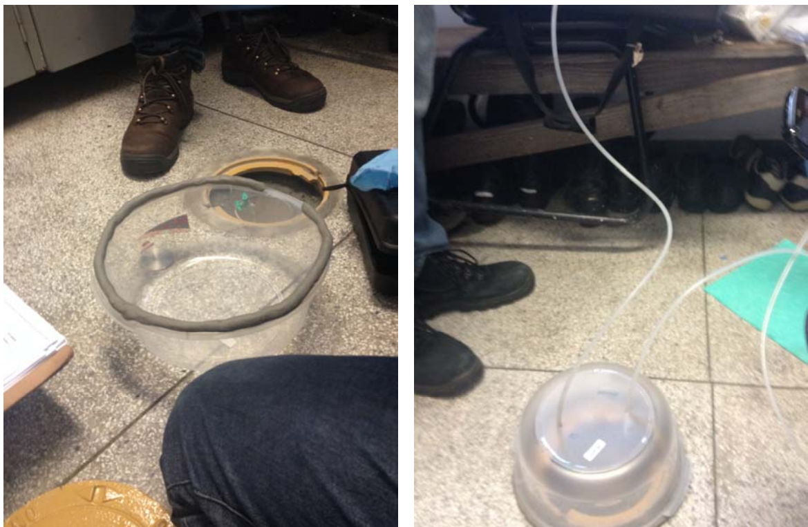
Figura 4.1 Fotos da vedação e instalação de campânula para Teste de Estanqueidade
