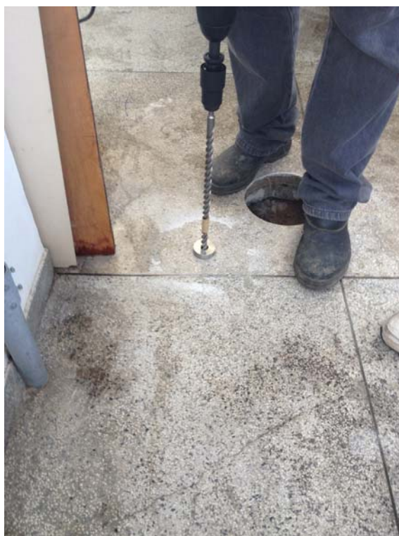
Figura 3.1.1 Fotos das perfurações no piso para instalação de PMGs
