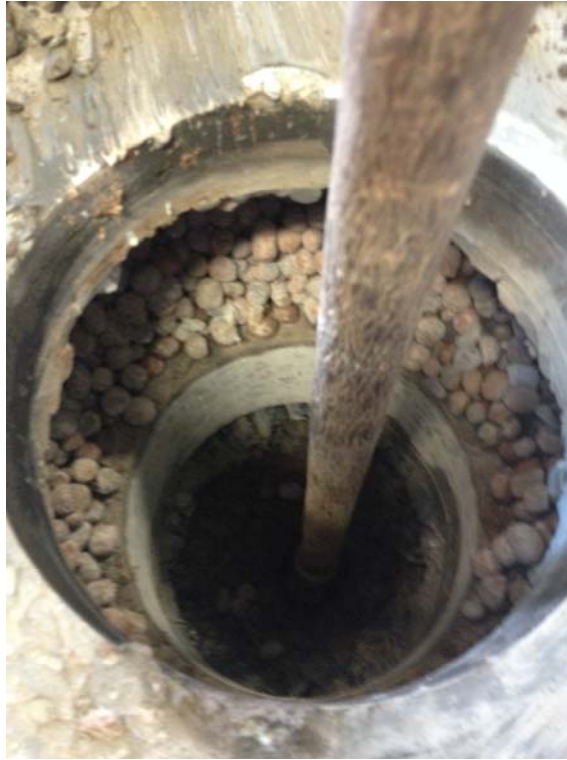
Figura 3.1.5 Visualização de segunda laje na Portaria P3
