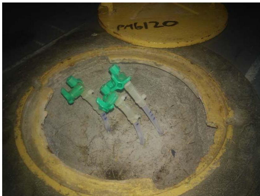
Figura 3.1.6 Trio de Poços de Monitoramento finalizado
