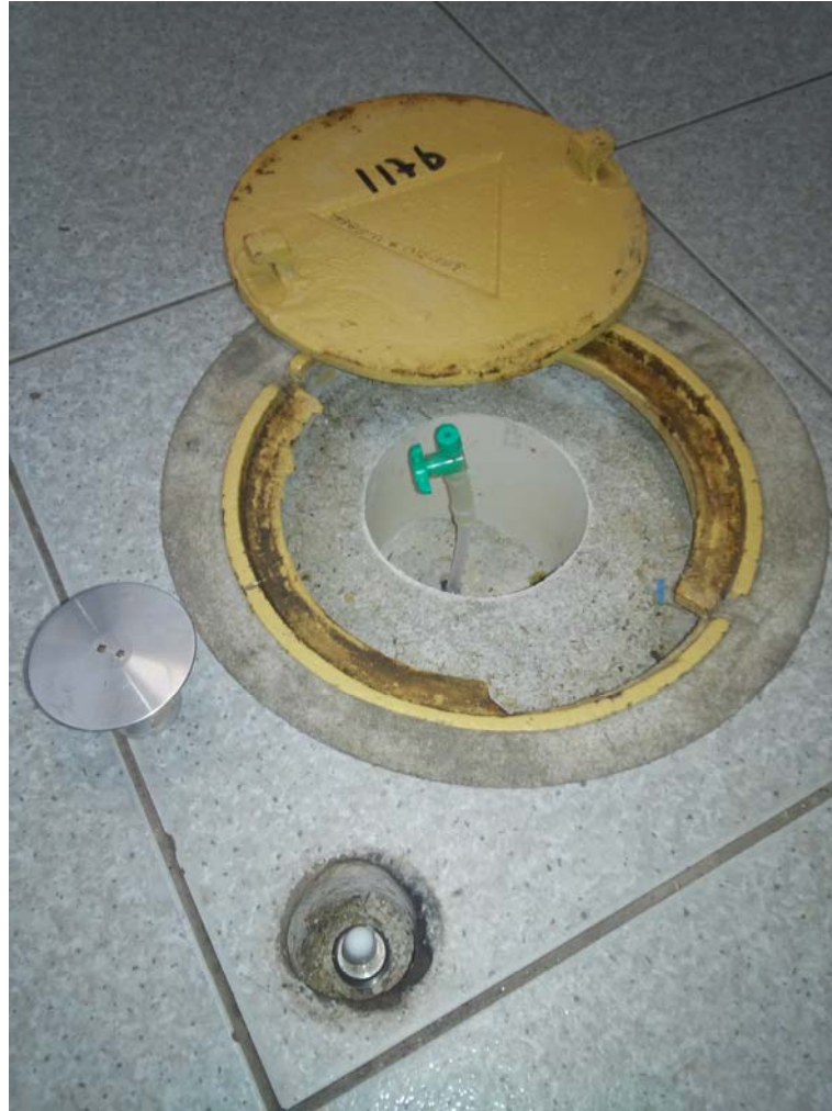
Figura 3.1.4 Par de Poços de Monitoramento finalizado
