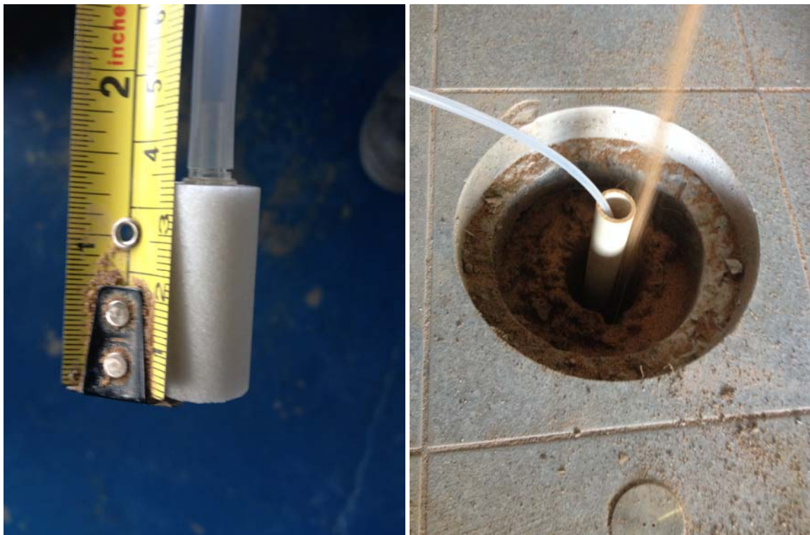
Figura 3.1.3 Instalação do PMG-B
