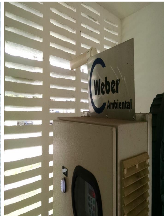
Abrigo com exaustão direcionada para o elemento vazado
