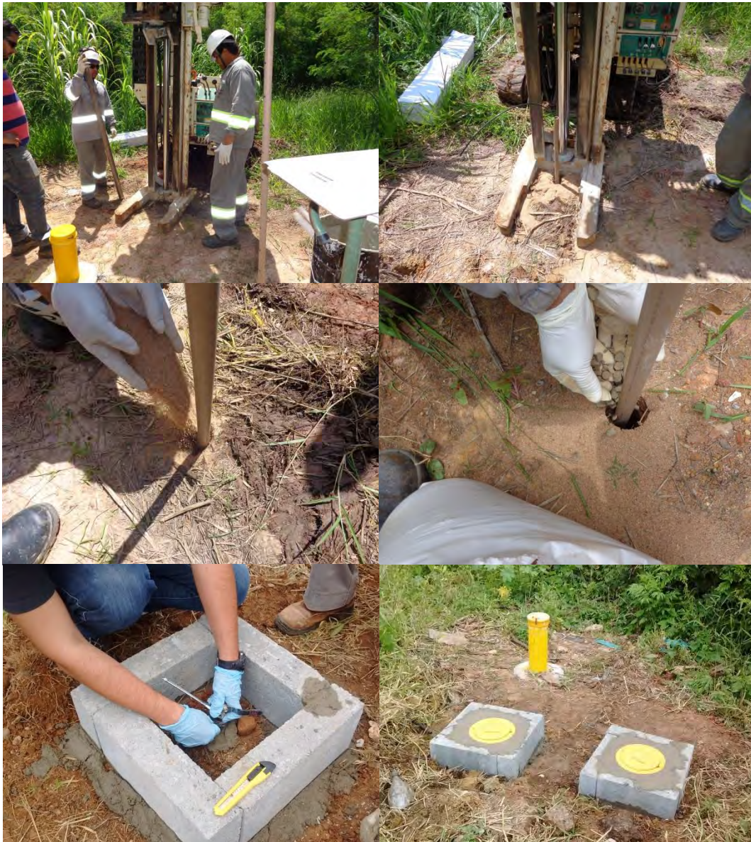
Figura 18 – Instalação dos poços de monitoramento de gases no solo
