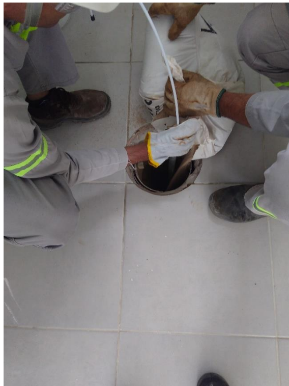
Foto 04 – Colocação de areia pré-filtro do poço com filtro de pedra porosa, instalado na zona não saturada
