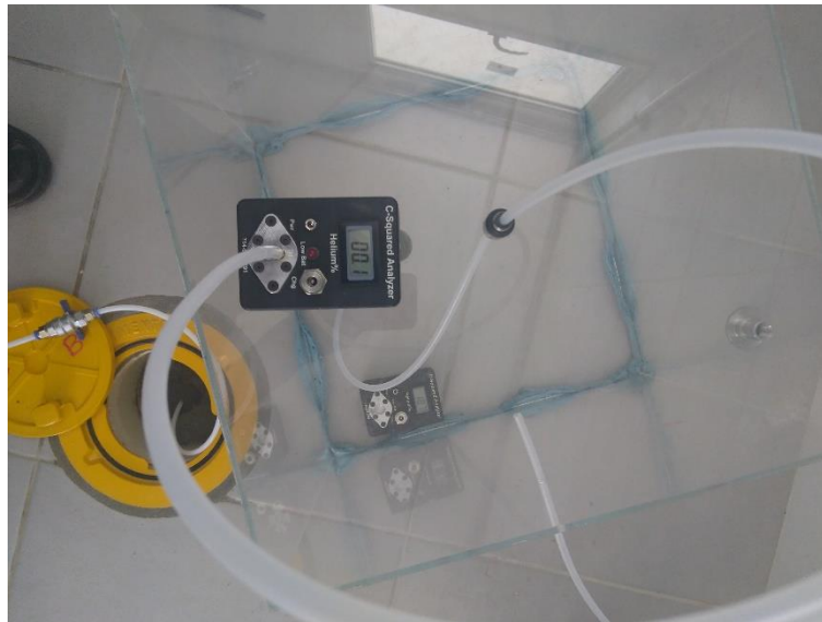
Foto 11 – Teste de estanqueidade no poço de monitoramento de gases no contrapiso ( subslab )
