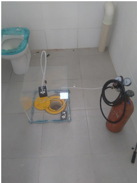
Foto 10 – Teste de estanqueidade no poço de monitoramento de gases na zona não saturada
