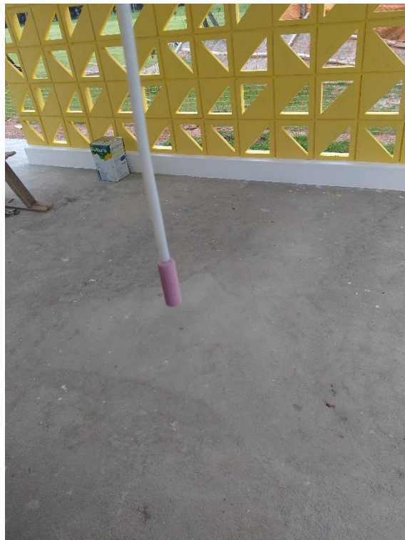
Foto 02 – Filtro de pedra porosa do poço instalado na zona não saturada
