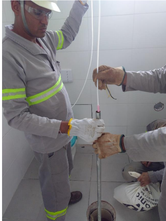
Foto 03 – Instalação do poço com filtro de pedra porosa, instalado na zona não saturada
