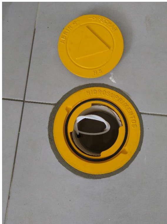
Foto 06 – Acabamento do poço com filtro de pedra porosa, instalado na zona não saturada
