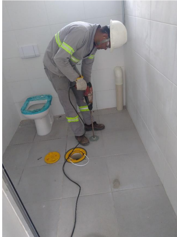
Foto 07 – Perfuração para instalação do poço subslab
