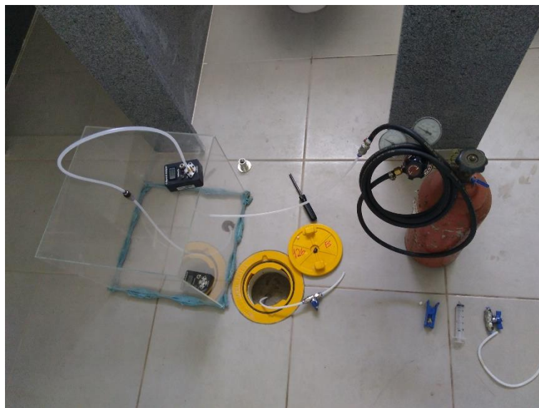
Foto 03 – Teste de estanqueidade nos poços de monitoramento de gases no contrapiso
