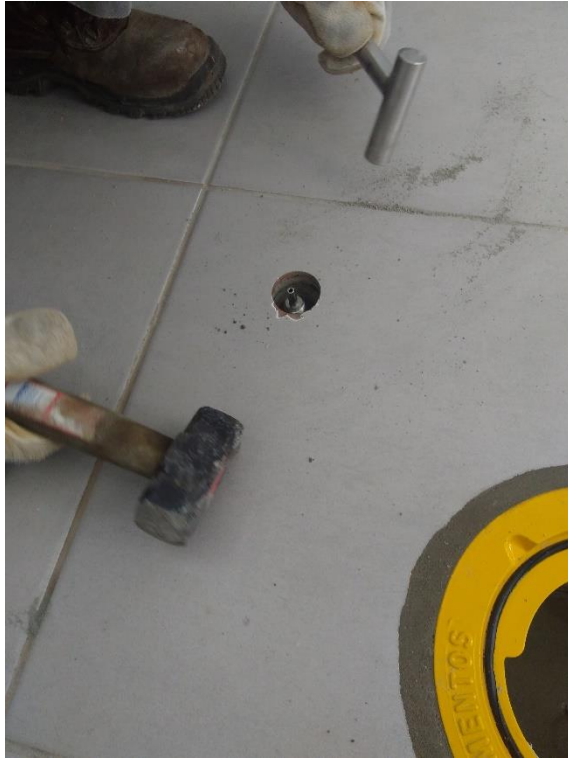
Foto 09 – Instalação do dispositivo vapor pin
