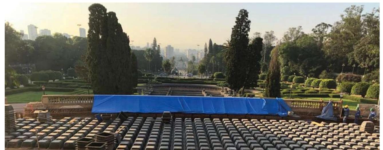
Preparação das formas para concretagem da laje de cobertura do subsolo
