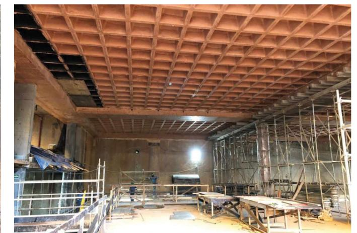
Área do subsolo com a laje de cobertura concretada
