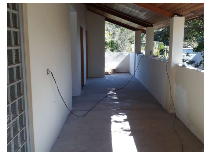
Extensão da circulação da edificação anexa
