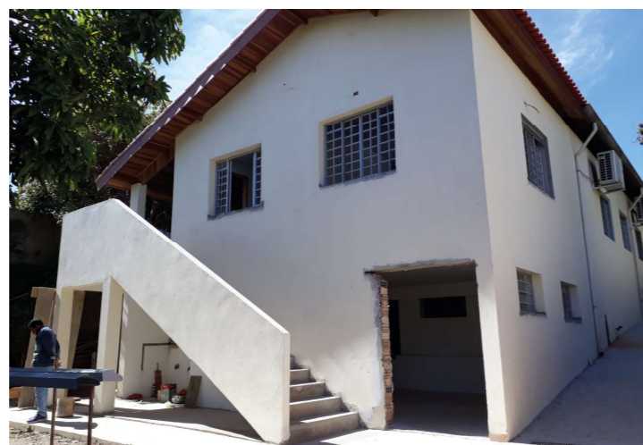
Vista geral da ampliação do anexo
