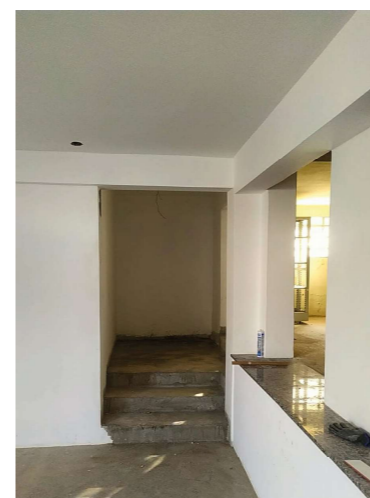
Ampliação do pavimento inferior
