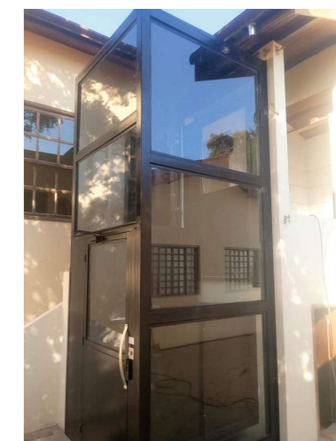
Instalação de elevador externo
