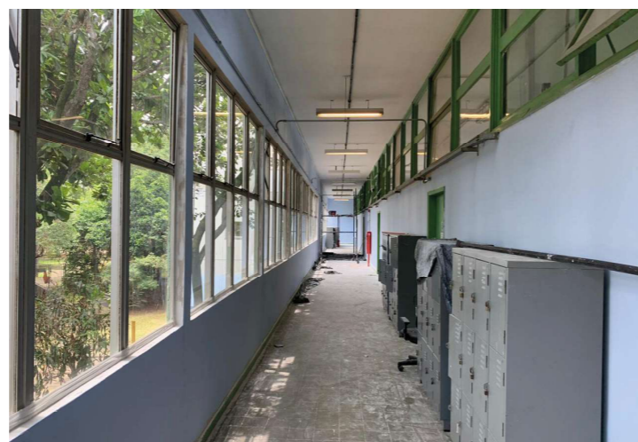
Intervenções na circulação para instalação de equipamentos de segurança
