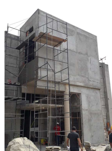
Construção de torre de elevador
