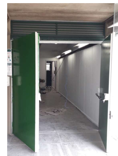
Instalação de portas com barra antipânico
