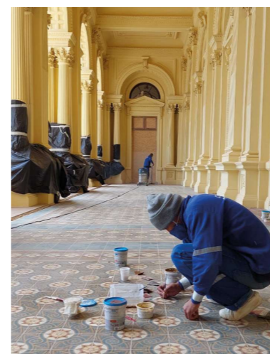
Restauração de pisos
