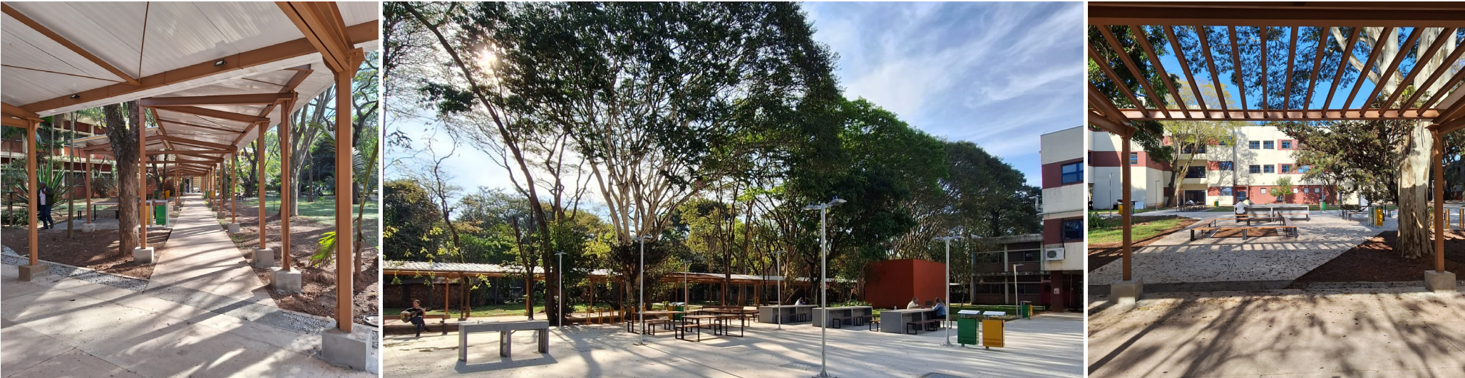
Reforma da Marquise e Espaço de Vivência do Instituto de Psicologia Crédito: Arquivo SEF
